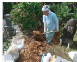
10月になって涼しくなってきましたが穴掘りの作業は汗をかきます！
