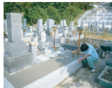
雑草予防で墓所内にモルタルを敷き均しました。
