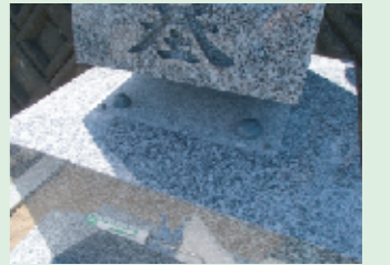
各部材の接続部分と目地には耐震性コーキング剤を使用します。
