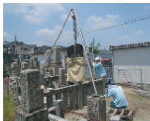
奈良県御所市でお墓の改修工事です。高さ約2.3m、重さ約1tのお墓を手作業で吊り上げています。
