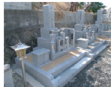
堺市内にてT様墓所改葬工事が完成しました。
